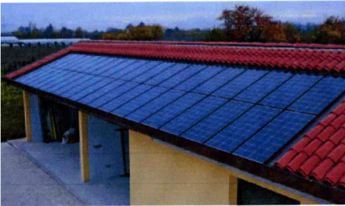
(tetto a falda con moduli che coprono una parte della copertura)
