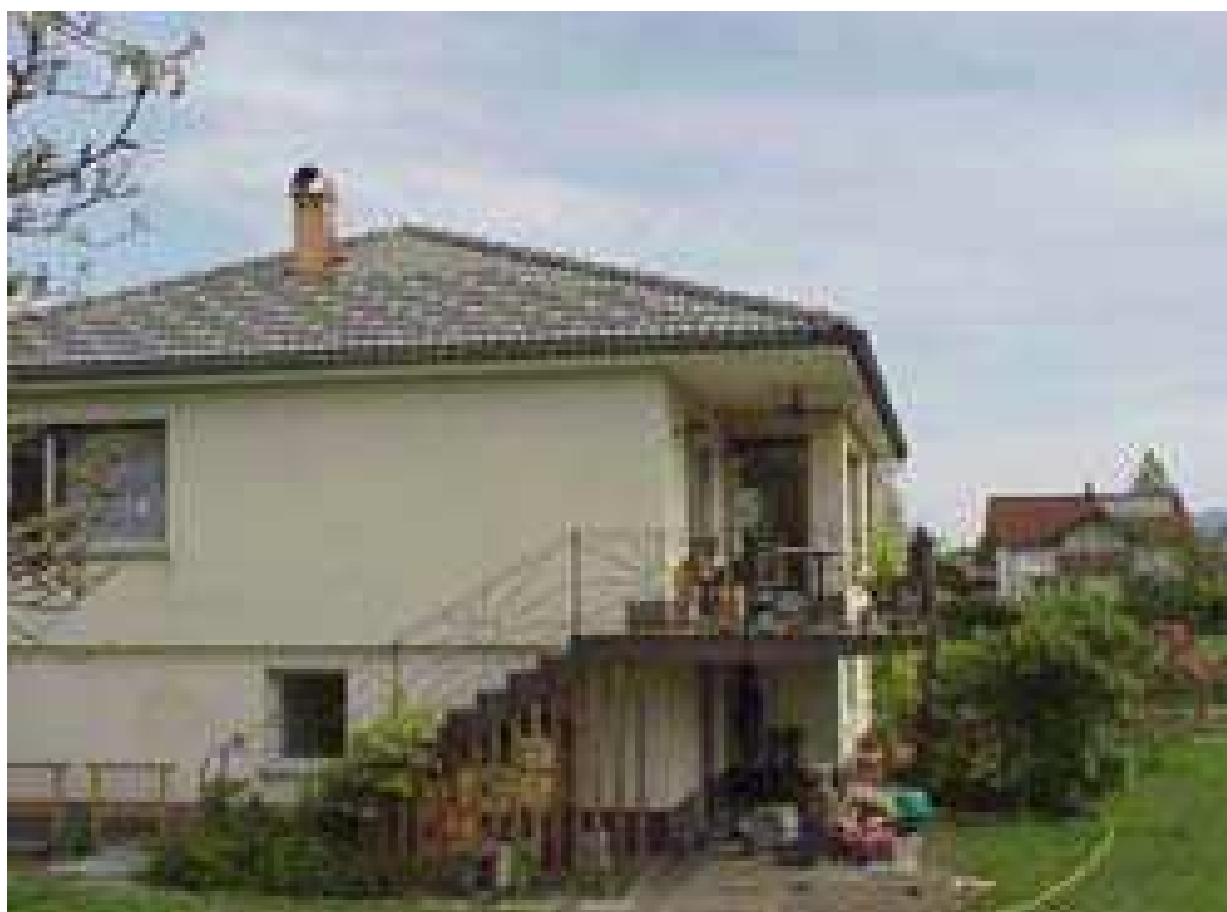
Tetto solare premiato a Fußach (Vorarlberg, Austria).
