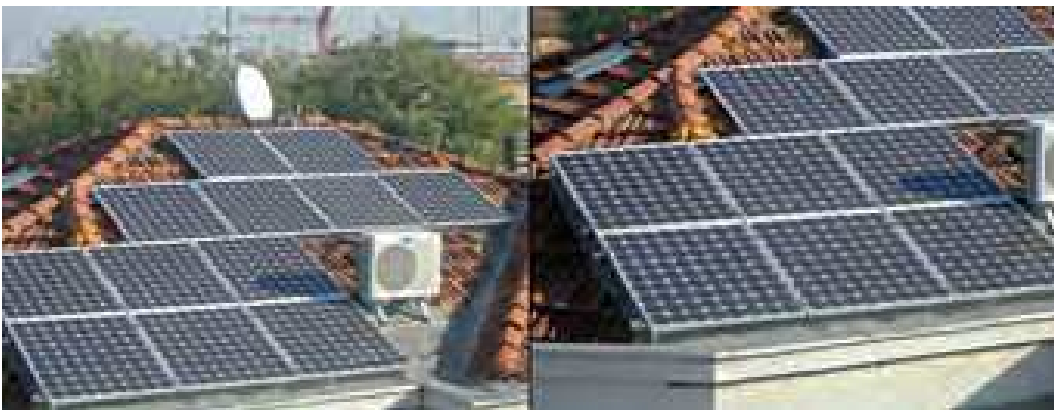
negativo (tetto a falda con moduli che coprono una parte della copertura)
